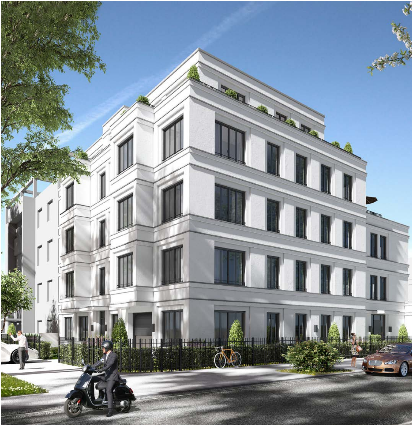
AENGEVELT vermittelt projektierte Neubau-Eigentumswohnungen in bester Wohnlage des Düsseldorfer Zooviertels. AENGEVELT brokers planned freehold flats that are to be constructed in the best residential location of Düsseldorf's Zooviertel.
