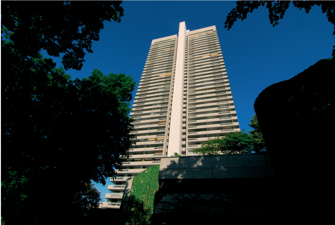
Bild 1: Die Sanierung des Colonia-Hochhauses in Köln stellt besondere Anforderungen an die Planung und Ausführung.
