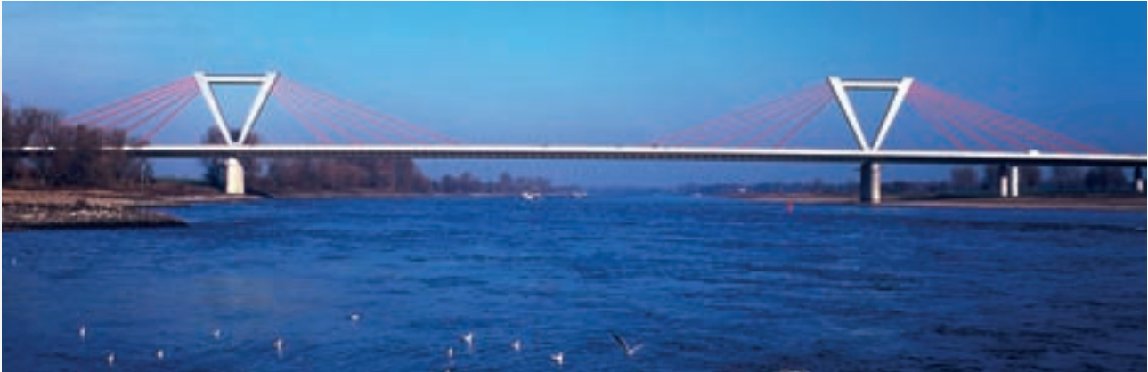
Rheinbrücke im Zuge der A 44, Baustatische Prüfung der Vorlandbrücken Auftraggeber: Landesbetrieb Straßenbau NRW
