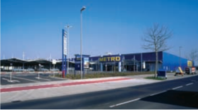
Metromarkt in Neuss Auftraggeber: METRO Großhandels-gesellschaft mbH
