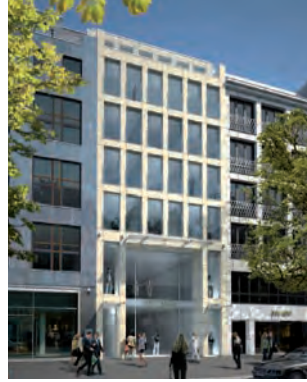
Left: KWS183, Kaiserswerther Straße Next to it: Kö 88 on Königsallee Below: Siemens in the Airport City
